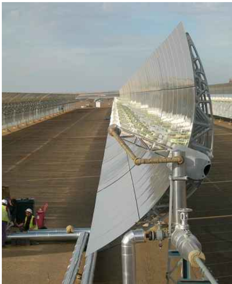
Un colector cilíndrico-parabólico de Sener en la planta termosolar de Badajoz ARCHIVO
